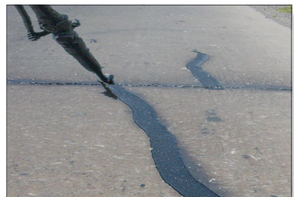
TOMADO DE JUNTAS , GRIETAS Y FISURAS
