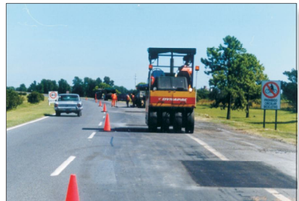
TAREAS DE BACHEO REALIZADAS POR SERVICIOS VIALES
